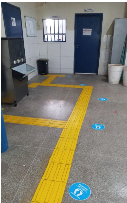
Figura 33 - Piso tátil no pátio interno
