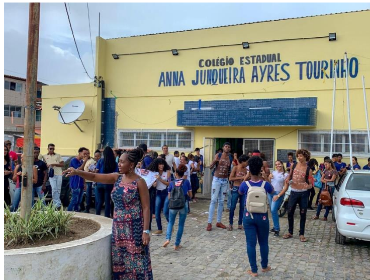
Figura 30 - Fachada da escola
