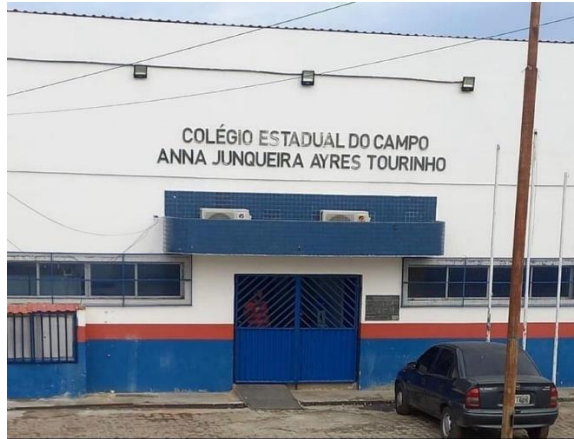
Figura 29 - Fachada da escola após a reforma de 2022
