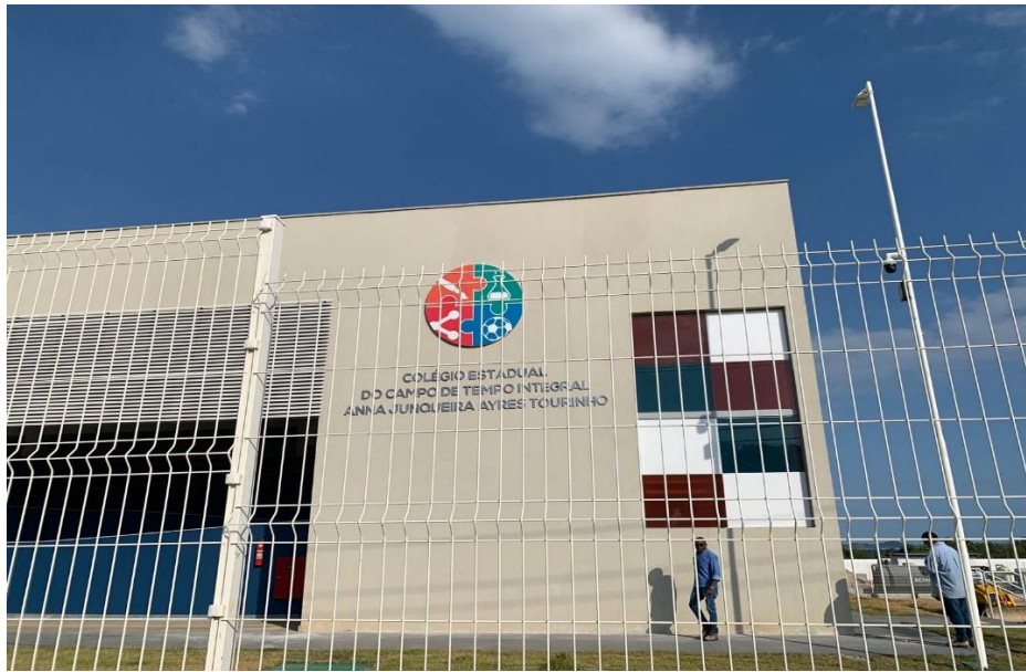
Figura 26 - Fachada da escola
