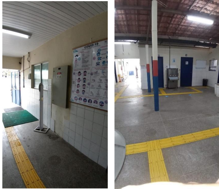
Figura 31 - Vista do corredor e do pátio interno
